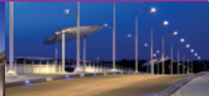
Les luminaires routiers
