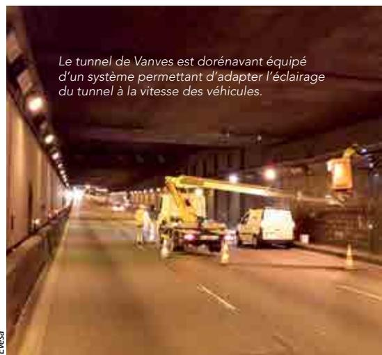
Le tunnel de Vanves est dorénavant équipé d'un système permettant d'adapter l'éclairage du tunnel à la vitesse des véhicules.
