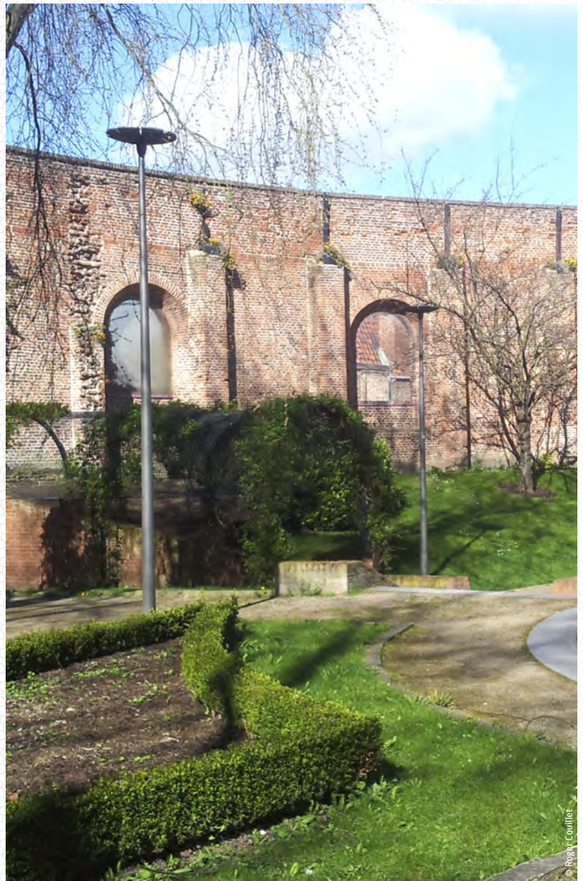
Luminaires d'éclairage extérieur à leds se trouvant sur le site des jardins de la Fonderie à Douai (Nord).
