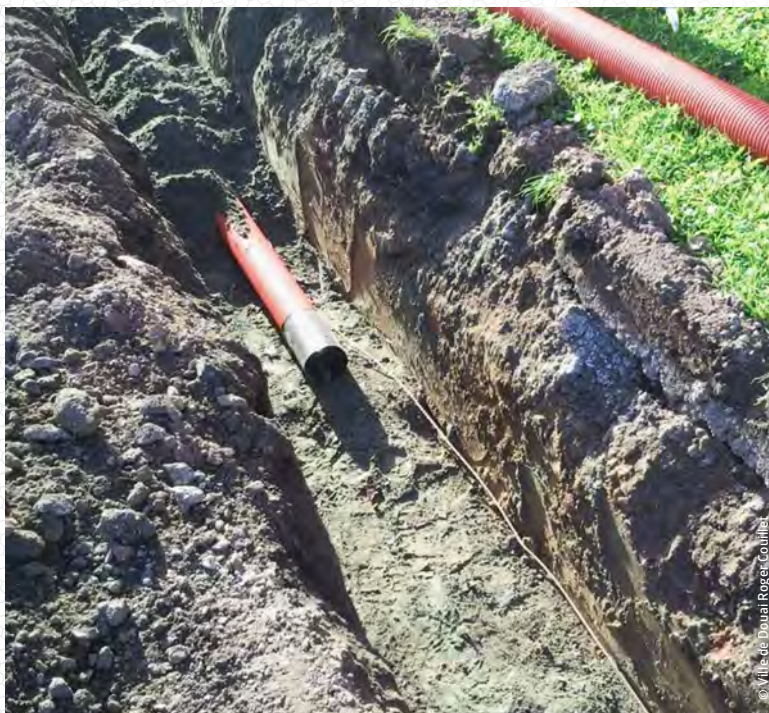
Pose d'infrastructure pour l'éclairage extérieur en tranchée.
