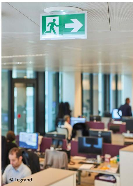
**45** Les foyers lumineux doivent avoir un flux lumineux assigné d'au moins **45 lumens** pendant la durée de fonctionnement assignée
